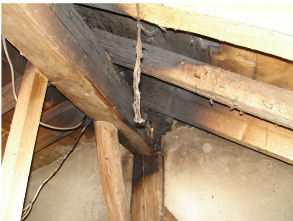
Selbstentzündung durch Hornissennest.
