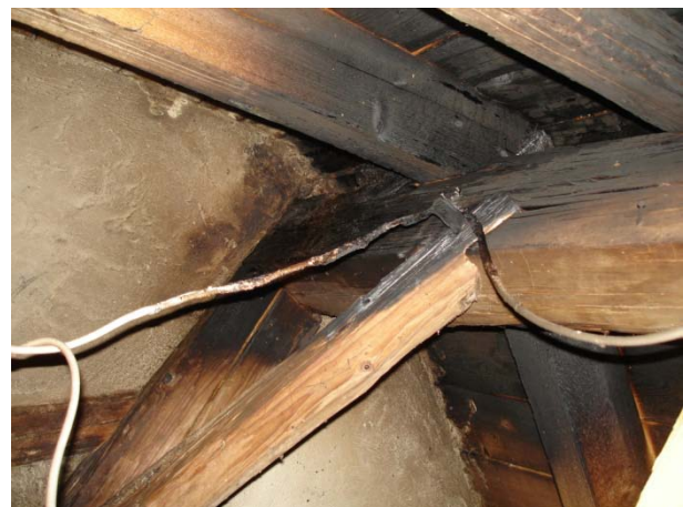
Selbstentzündung durch Hornissennest.
