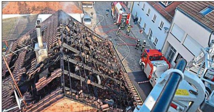
Der Dachstuhl des Wohnhauses brannte komplett aus. Die Feuerwehr konnte gerade noch verhindern, dass die Flammen auf die Nachbarhäuser übergreifen.
