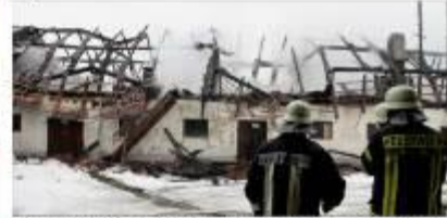
Komplett niedergebrannt ist das landwirtschaftliche Nebengebäude.
