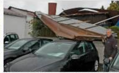
Josef Anthonhammer in Eging vor der zerstörten Flachdach-Infrastruktur im Ortsteil Sandbach.
