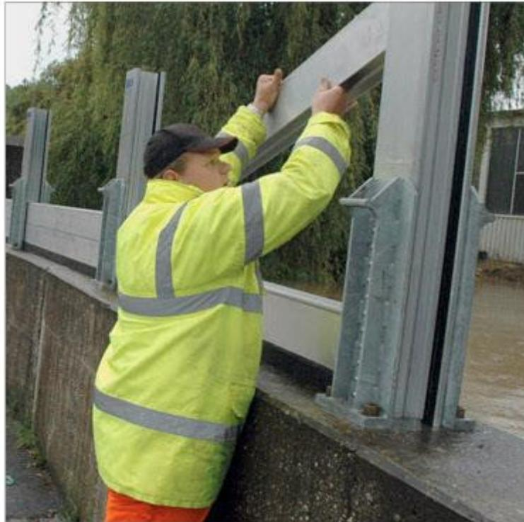
**In Windorf** ist der Hochwasserschutz deutlich erkennbar: Eine Betonmauer wird zusätzlich mit Dammbalken aus Aluminium erhöht. Aber es gibt noch Lücken. – Foto: Rücker
