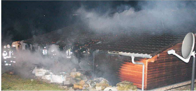
Dichter Rauch steht über dem Holzhaus in Lenzenrodt. Im angebauten Raum war das Feuer ausgebrochen. Der Eigentümer musste sich durch die Flammen kämpfen. Er erlief dabei allerdings lebensgefährliche Verletzungen. – Foto: Martin Resch/rogerimages.de
