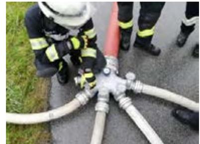
*Bau der Förderleitung von der Donau zum Tanklager*
