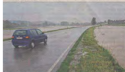
Links und rechts der Staatsstraße haben sich gegen 18 Uhr richtige Seen gebildet. An einigen Stellen läuft das Wasser über die Fahrbahn.
