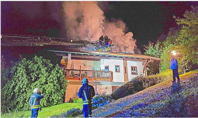
150 000 Euro Schaden sind beim Brand des Dachstuhls eines Wohnhauses in Bad Griesbach in der Nacht zum Samstag entstanden. Vermutlich hat ein defekter Heizlüfter das Feuer ausgelöst. – Foto: Helmut Degenhart/zema-medien.de
