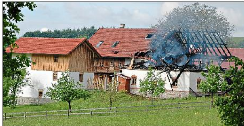
Durch gezielten Objektschutz konnten auf dem teilweise renovierten Sacherl das Seitengebäude im Vordergrund komplett sowie das Haupthaus dahinter teilweise vorm Feuer bewahrt werden. Letzteres ist nach Polizeiangaben unbewohnbar. – Fotos: Nöbauer
