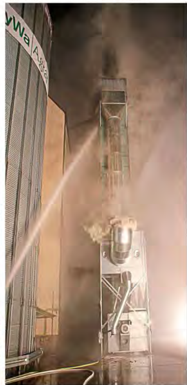
Stundenlang mussten die Feuerwehren den erhitzten Turm mit dem Wasserstrahl kühlen.
