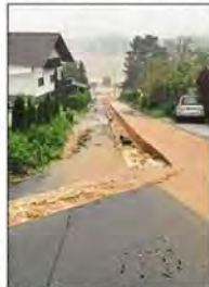
In Unteriglbach laufen Kanalbauarbeiten. Das Wasser riss alles mit.
