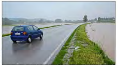
Links und rechts der Staatsstraße haben sich gegen 18 Uhr richtige Seen gebildet. An einigen Stellen läuft das Wasser über die Fahrbahn.
