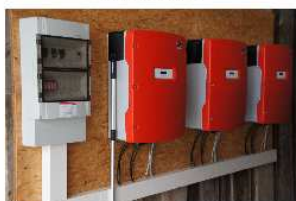
Wechselrichter / Sicherungskasten
